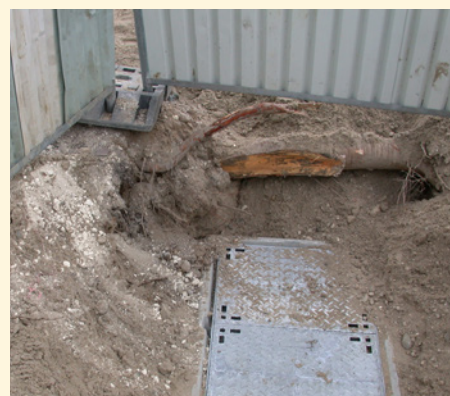
Racines endommagées par une tranchée
