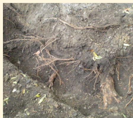
Racines endommagées par une tranchée
