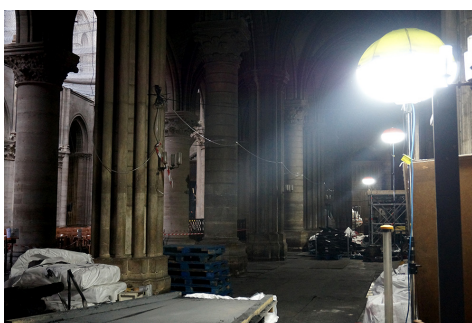
Ballons de chantier sur le site de Notre Dame de Paris
